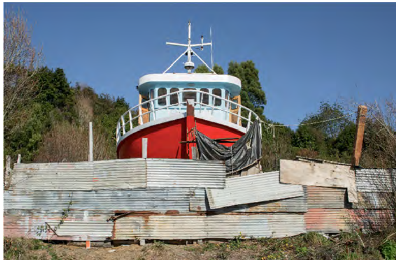
Imagen 28: Embarcación en proceso de construcción, San Rafael - Caracolito, Calbuco
